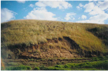
Début de glissement de terrain
