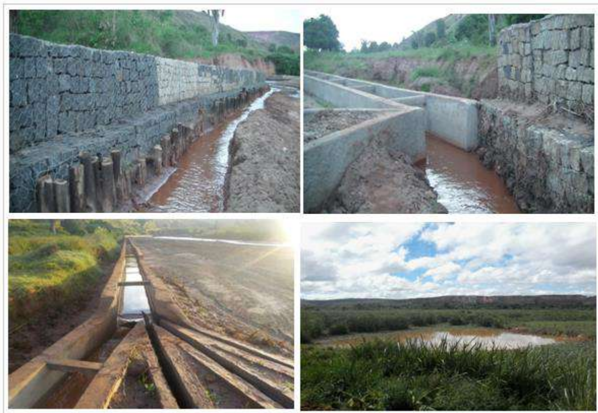
Bassin de retenue d'eau au FOFIFA CALA à Ambohitsilaozana avec les canaux d'amener d'eau
